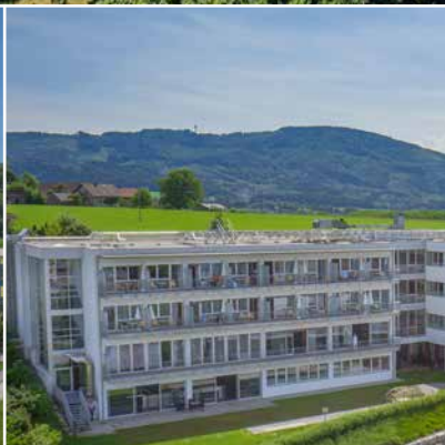
Revalidatiecentrum Oberndorf, Oostenrijk
